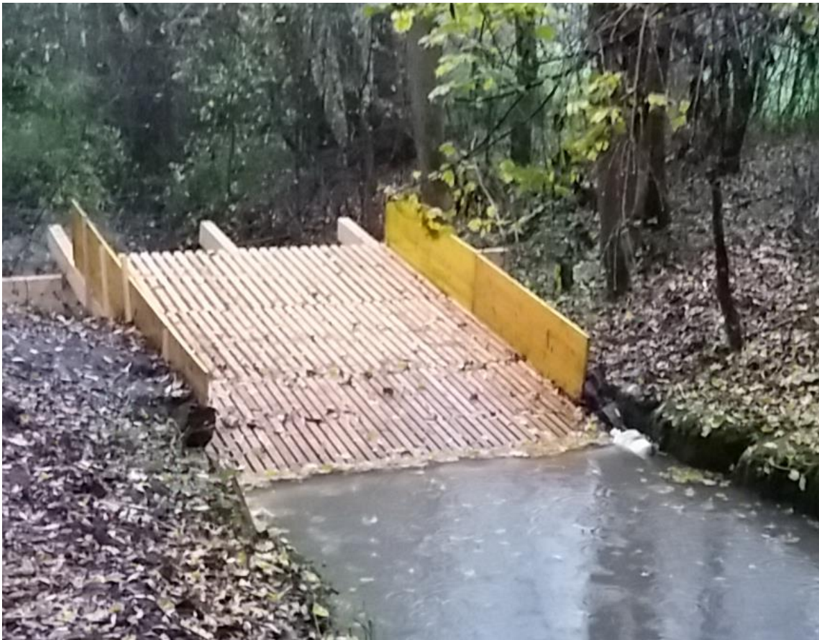
Abb. 1: Verwendung einer Rechenanlage, bestehend aus drei Rechensegmenten, eingebaut im Abflusskanal unterhalb des Dammes des Hochwasserrückhaltebeckens Sulzbach zum Abfischen des Fischbestandes beim Ablassen des Stausees (Gebaut von Norbert Bacher, Paul Reder und Team von SFV Schönaich-Steinenbronn nach Plänen von Hubert Wnuck, LFVBW)
